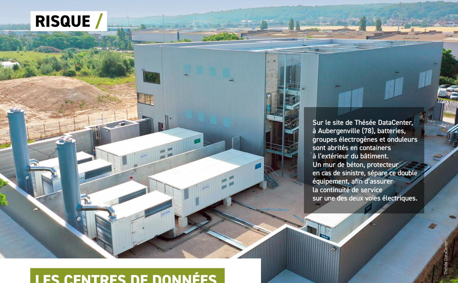
Sur le site de Thésée DataCenter, à Aubergenville (78), batteries, groupes électrogènes et onduleurs sont abrités en containers à l'extérieur du bâtiment. Un mur de béton, protecteur en cas de sinistre, sépare ce double équipement, afin d'assurer la continuité de service sur une des deux voies électriques.
